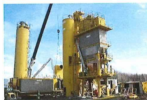
Tymczasowy Zakład Wytwórní Mas Bitumicznych w Szczecinku
